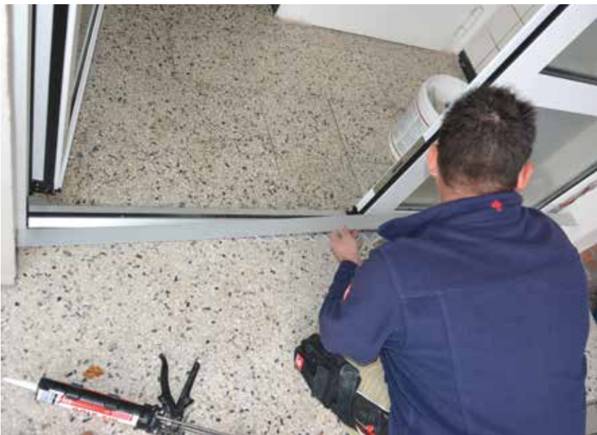
Einlegen der Alu-Schiene ins Klebstoffbett mit Montagekleber © Henkel AG & Co. KGaA
